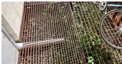
Regenwasser wird über horizontale Verlängerung des Fallrohrs im Abstand von 40 - 50cm zur Fassade versickert.
