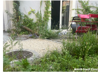
Schaffhauserstrasse, Zürich Nachträgliche Dachwasserversickerung über eine oberflächennahe Rinne, die in die nahe gelegene Begrünung führt.
