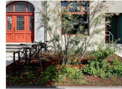
Zürich, Haus Eber Das Dachwasser des Altbaus wird in mit Gittern überdeckte Mulden geleitet. Dadurch kann die Fläche multifunktional genutzt werden: bei Regenwetter kann Wasser einstauen und die Fläche bleibt trotzdem für den Zugang und Veloparkierung verfügbar.
