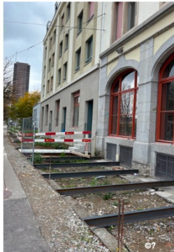
Während der Bauzeit: Magerbetonstreifen an der Hauswand verhindert direktes Eindringen des Regenwassers und ist gleichzeitig Auflager für die Stahlträger der Gitterroste
