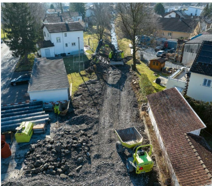
Rückbau des technischen Gerinnes und Vorbereitung der Baustrasse.
