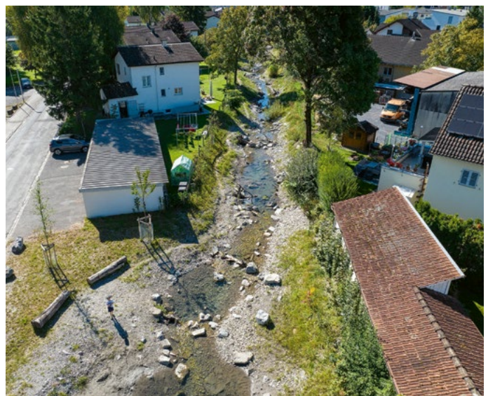
Der Sevelerbach nach der Revitalisierung mit erhöhter Struktur- und Strömungsvielfalt, vielfältiger Bepflanzung sowie Trampelpfad und Sitzmöglichkeiten.
