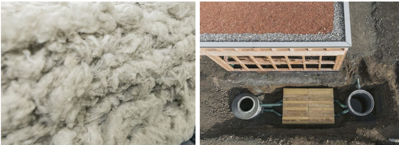
Fig. 1 Steinwolle während der Herstellung in Flums (links) und Anwendung zur Regenwasserretention in der Schweiz (rechts). (© Flumroc)
