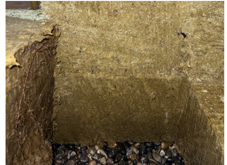
Eingebaute Steinwolle mit Kapillaraufstieg
