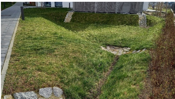
Abbildung 8: Drainageleitung an der Gebäudefassade (Fassung von Sickerwasser)
