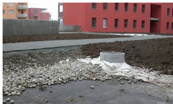
Abbildung 6: Drainage eines Tiefgaragendachs mit Bitumenbahn
