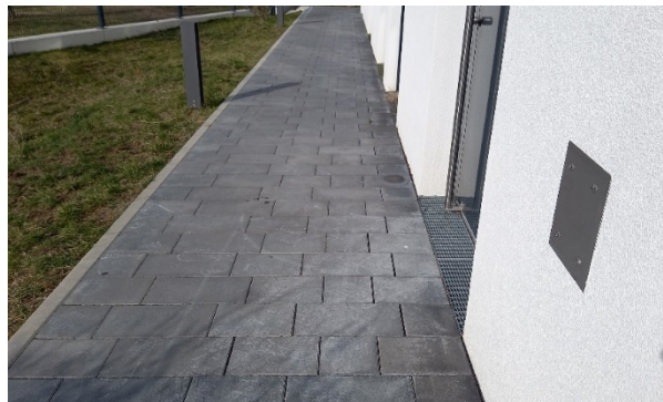
Abbildung 4: Wasserdurchlässiger Belag ohne Fugenbegrünung
