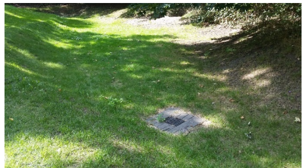
Abbildung 9: Versickerungsmulde, zusätzlich mit Ableitung in die Regenwasserkanalisation
