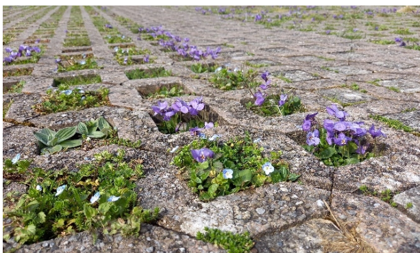
Abbildung 4: Parkplatz mit wasserdurchlässigen, begrünten Rasengittersteinen
