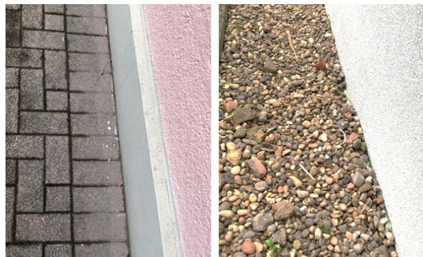
Abbildung 5: Wasserdurchlässiger Pflasterbelag (links) und Kiesstreifen an der Fassade (rechts)
