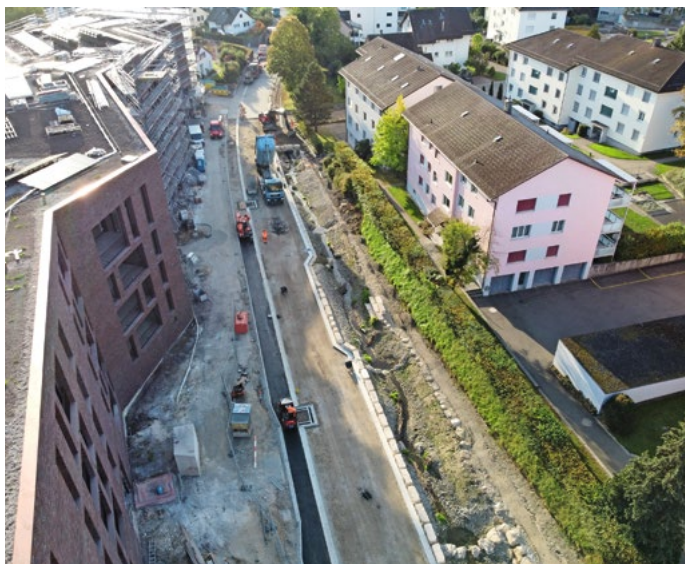
2023: während der Bauphase.
