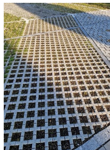
Grille gazon Quadro avec substrat de remplissage de la société Forster.
