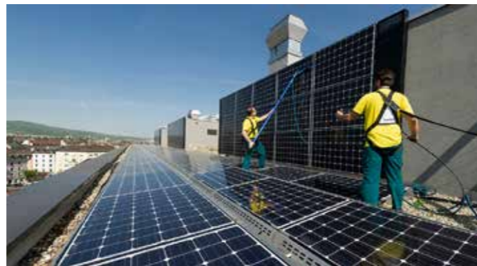
Abb. 6: Pflege- und Instandhaltungsarbeiten bei begrünten (oben, © Helix Pflanzensysteme GmbH) und PV-Fassaden (unten, © Hägni AG)
