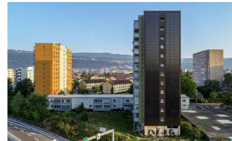
Abb. 60: Sanierung Hochhaus Aegerterstrasse in Biel. Um die Anforderungen an Hochhausfassaden zu erfüllen, wurden an der Aegertenstrasse spezielle Fassadenmodule verbaut (© 3S Solar Plus)
