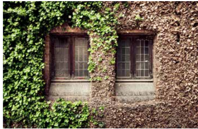
Abb. 28: Abgestorbene Pflanzenreste erhöhen die Brandgefahr und sind regelmässig zu entfernen (© gartenjournal.net)
