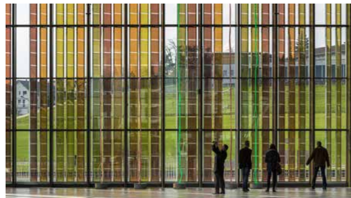
Abb. 46: Transparente, farbige PV-Module gestalten die Fassade des SwissTech Convention Center in Lausanne (© Mediacom EPFL)
