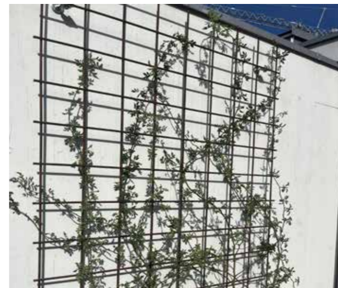
Abb. 20: Verschiedene Fassadebegrünungssysteme, welche eine spezifische Gestaltung ermöglichen (oben links: bodengebundene Fassadebegrünung mit einem Seilsystem als Kletterhilfe © Adobe Stock, oben rechts: bodengebundene Fassadebegrünung mit einem Selbstklimmer © Adobe Stock, unten links: bodengebundene Fassadebegrünung mit einem Stahlgitter als Kletterhilfe © Livio Keiser, unten rechts: wandgebundene Fassadebegrünung © Adobe Stock)
