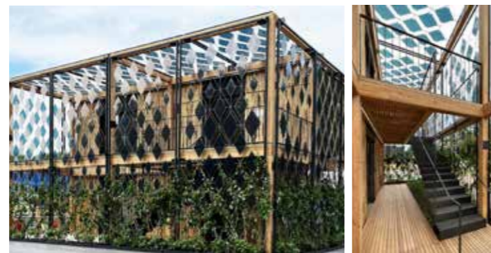
Abb. 113: Hortus, Allschwil bei Basel, bewegliche, horizontale PV-Module an der Aussenfassade (links) produzieren Strom und dienen als Sonnenschutz, im Innenhof (rechts) wurde die Fassade begrünt (© Herzog & de Meuron)
