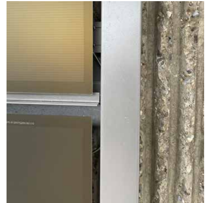
Abb. 67: Fertig installierte Brandabschottung zwischen zwei Modulen (© Silvia Domingo Irigoyen)
