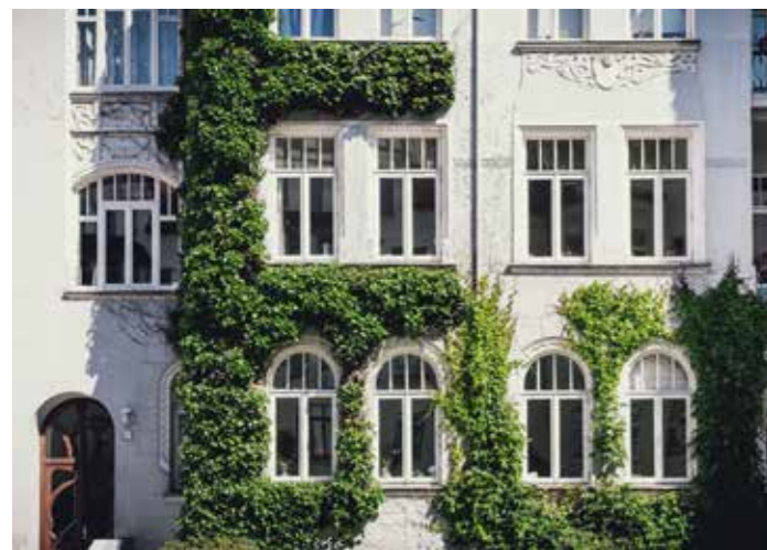
Abb. 21: Bodengebundene Begrünung, ein Überwachsen der Fenster kann durch eine entsprechende Pflege verhindert werden
