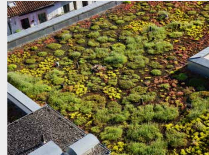
Abb. 12: extensives Gründach (© AdobeStock)
