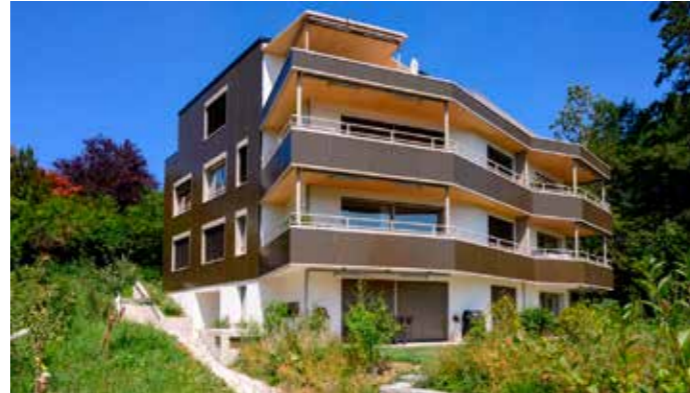
Abb. 48: Wohngebäude in Zürich, Höngg, opake PV-Module gestalten die Fassade des Wohngebäudes (© Kämpfen Zinke + Partner AG)
