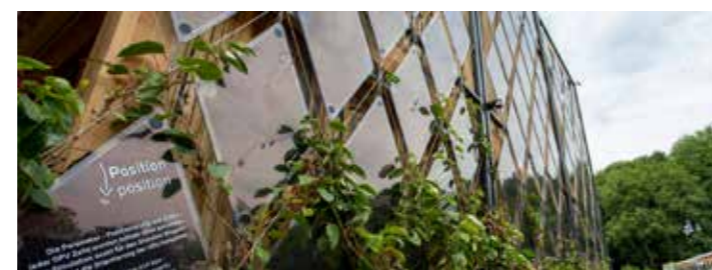
Abb. 114: SolarDecathlon 21/22 Eingabe von CoLLab, das Rankgerüst an der Fassade wird sowohl für PV-Module als auch Begrünung genutzt (© Lukas Fischer, HFT Stuttgart)
