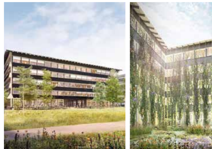
Abb. 113: Hortus, Allschwil bei Basel, bewegliche, horizontale PV-Module an der Aussenfassade (links) produzieren Strom und dienen als Sonnenschutz, im Innenhof (rechts) wurde die Fassade begrünt (© Herzog & de Meuron)
