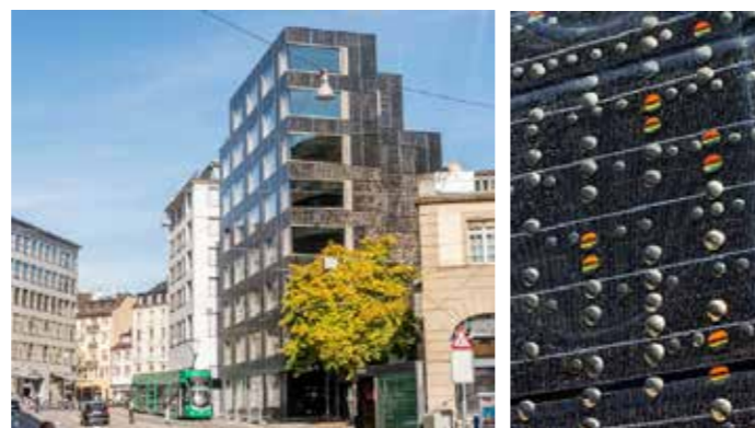
Abb. 49: Amt für Umwelt und Energie in Basel, individuell gestaltete PV-Module geben dem Gebäude seinen Ausdruck (© AUE)
