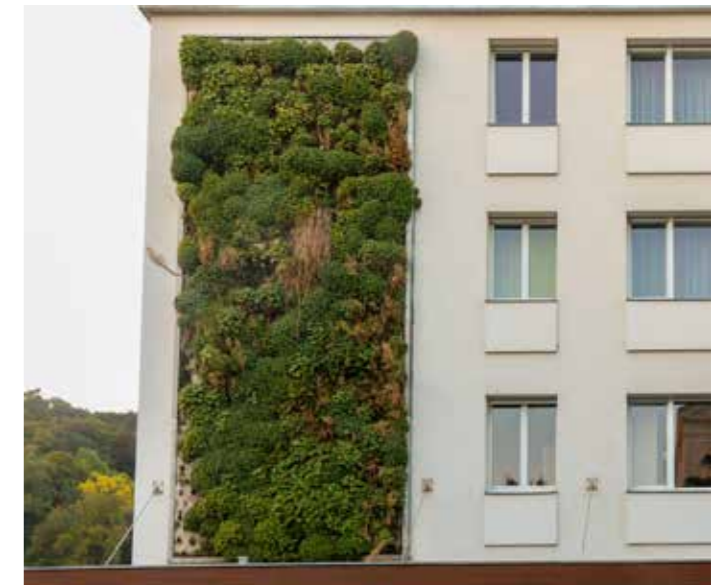
Abb. 20: Verschiedene Fassadebegrünungssysteme, welche eine spezifische Gestaltung ermöglichen (oben links: bodengebundene Fassadebegrünung mit einem Seilsystem als Kletterhilfe © Adobe Stock, oben rechts: bodengebundene Fassadebegrünung mit einem Selbstklimmer © Adobe Stock, unten links: bodengebundene Fassadebegrünung mit einem Stahlgitter als Kletterhilfe © Livio Keiser, unten rechts: wandgebundene Fassadebegrünung © Adobe Stock)
