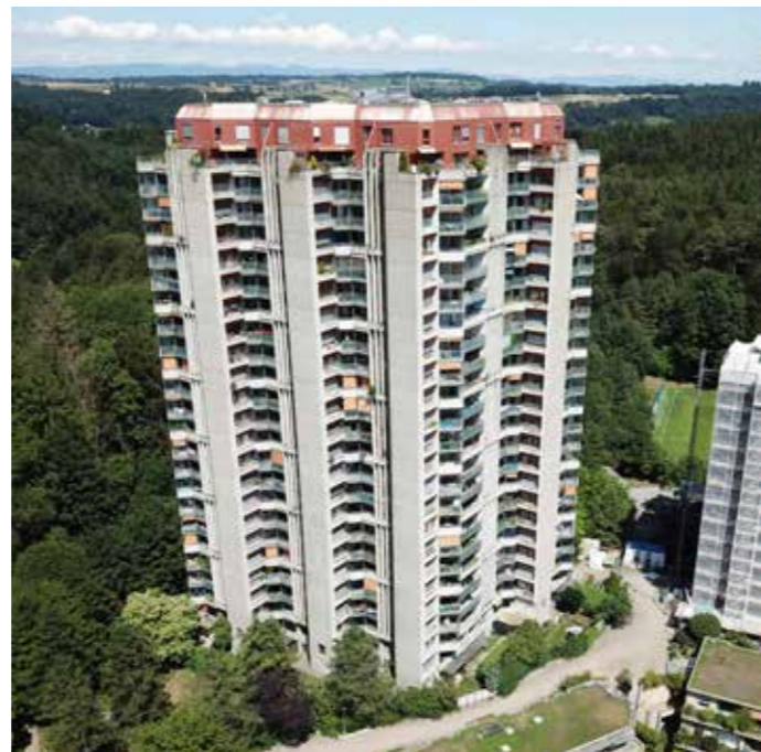
Abb. 62: Hochhaus Holenackerstrasse 65 in Bern (© Elektroplanung Schneider AG)
