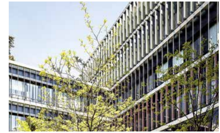
Abb. 5: Sanierung Bürogebäude Die Mobiliar in Bern, PV-Module vor den Fenstern als Sicht- und Sonnenschutz, gleichzeitig strukturieren die vertikalen Elemente die Fassade (© Kaspar Martig)
