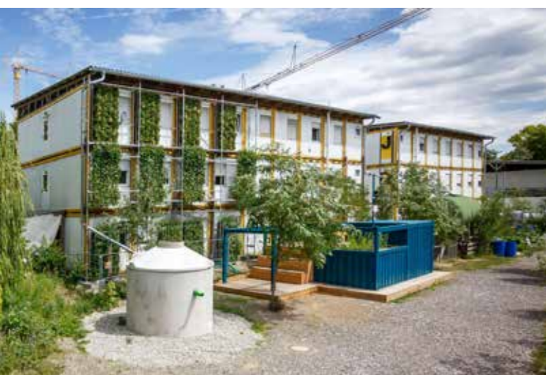
Abb. 25: Rosensteinviertel in Stuttgart, Versorgung der Fassadenbegrünung mittels gespeichertem Regenwasser und aufbereitetem Grauwasser (© J. Rettig).
