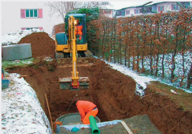
Fig. 6 Bau einer Rigolenversickerung mit Schlammsammler bei einer bestehenden Liegenschaft. Der Pufferspeicher nimmt das früher via Kanalisation abgeleitete Dach- und Platzwasser auf Construction d'un dispositif d'infiltration par fossé drainant avec collecteur de boue. La réserve de tampon recueille l'eau du toit et des chaussées anciennement évacuée par les canalisations
