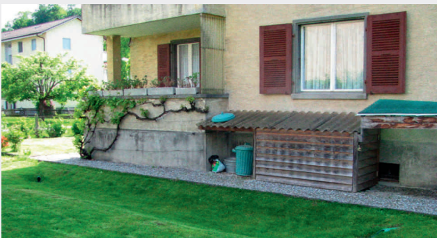
Fig. 3 Muldenversickerung für einen Altbau nach der Begrünung. Allfällige Schadstoffe im Regenabwasser von Dächern und Plätzen werden dank der Bodenpassage zurückgehalten und zum Teil von Mikroorganismen abgebaut
