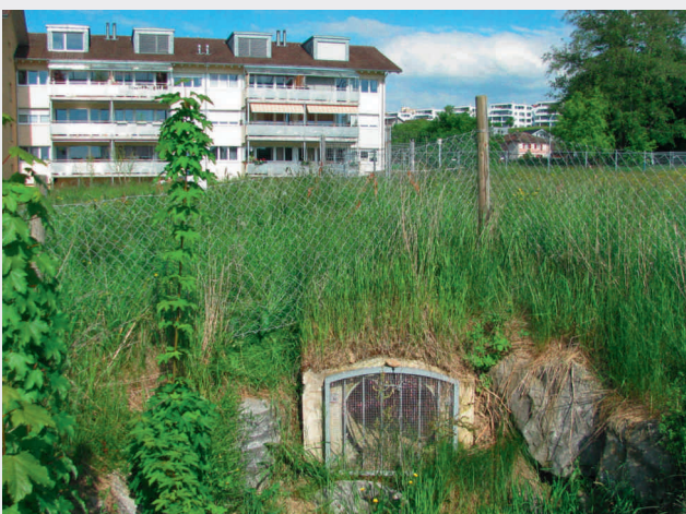
Fig. 4 Ist die Aufnahmekapazität der unterirdischen Versickerungsanlage im Oberfeld bei anhaltenden Niederschlägen erschöpft, fliesst das gefilterte Regenwasser über diesen Überlauf ab Lorsque la capacité d'absorption des systèmes d'infiltration souterrains à Oberfeld est atteinte en cas de précipitations permanentes, les eaux pluviales filtrées se déversent par ce trop-plein
