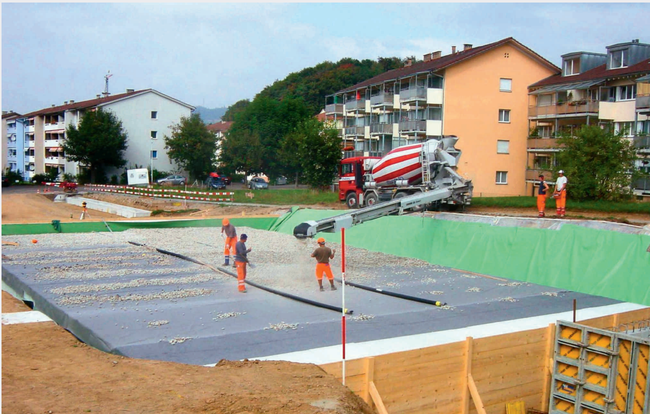
Fig. 7 Bau der schweizweit grössten unterirdischen Versickerungsanlage im Neubaugebiet Oberfeld der Berner Vorortsgemeinde Ostermundigen Construction du plus grand système d'infiltration souterrain de Suisse dans le nouveau quartier Oberfeld de la commune d'Ostermundigen
