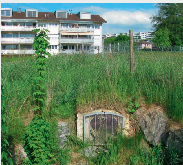
Fig. 4 Lorsque la capacité d'adsorption des systèmes d'infiltration souterrains à Oberfeld est atteinte en cas de précipitations prolongées les eaux pluviales filtrées se déversent par ce trop-plein.
