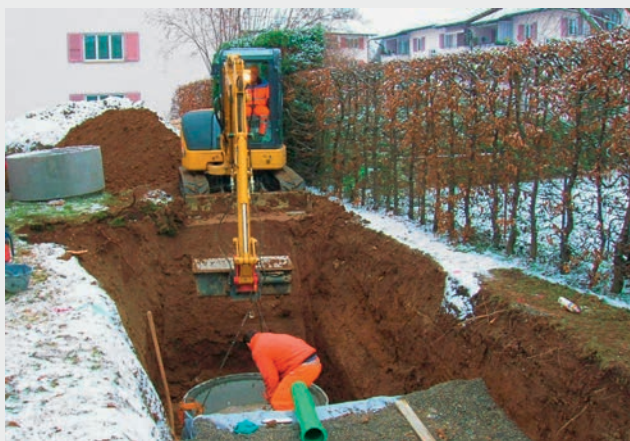
Fig. 6 Construction d'un dispositif d'infiltration par fossé drainant avec collecteur de boue. Le volume de rétention recueille l'eau du toit et des chaussées anciennement évacuée par les canalisations.
