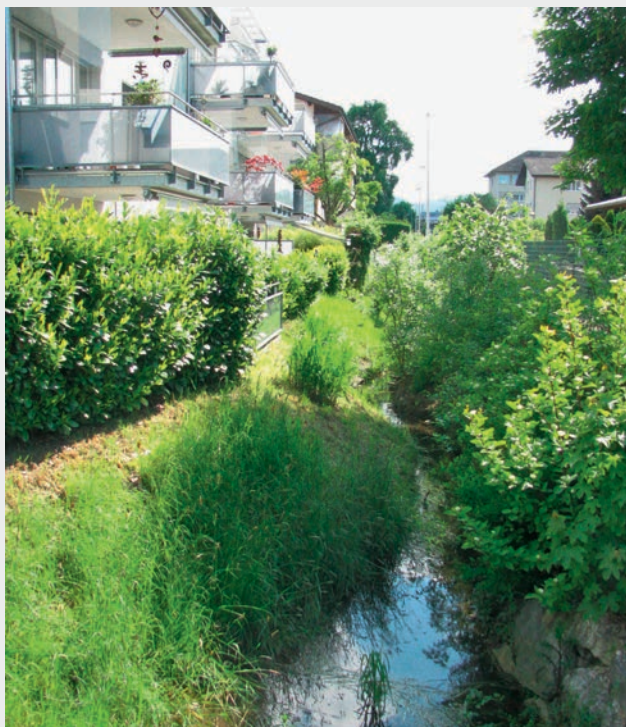
Fig. 5 La commune d'Ostermundigen a fait remettre en surface le cours d'eau anciennement enterré Löttschenbach. En cas de précipitations intenses, l'eau des trop-pleins des grands bassins d'infiltration s'y déverse également.
