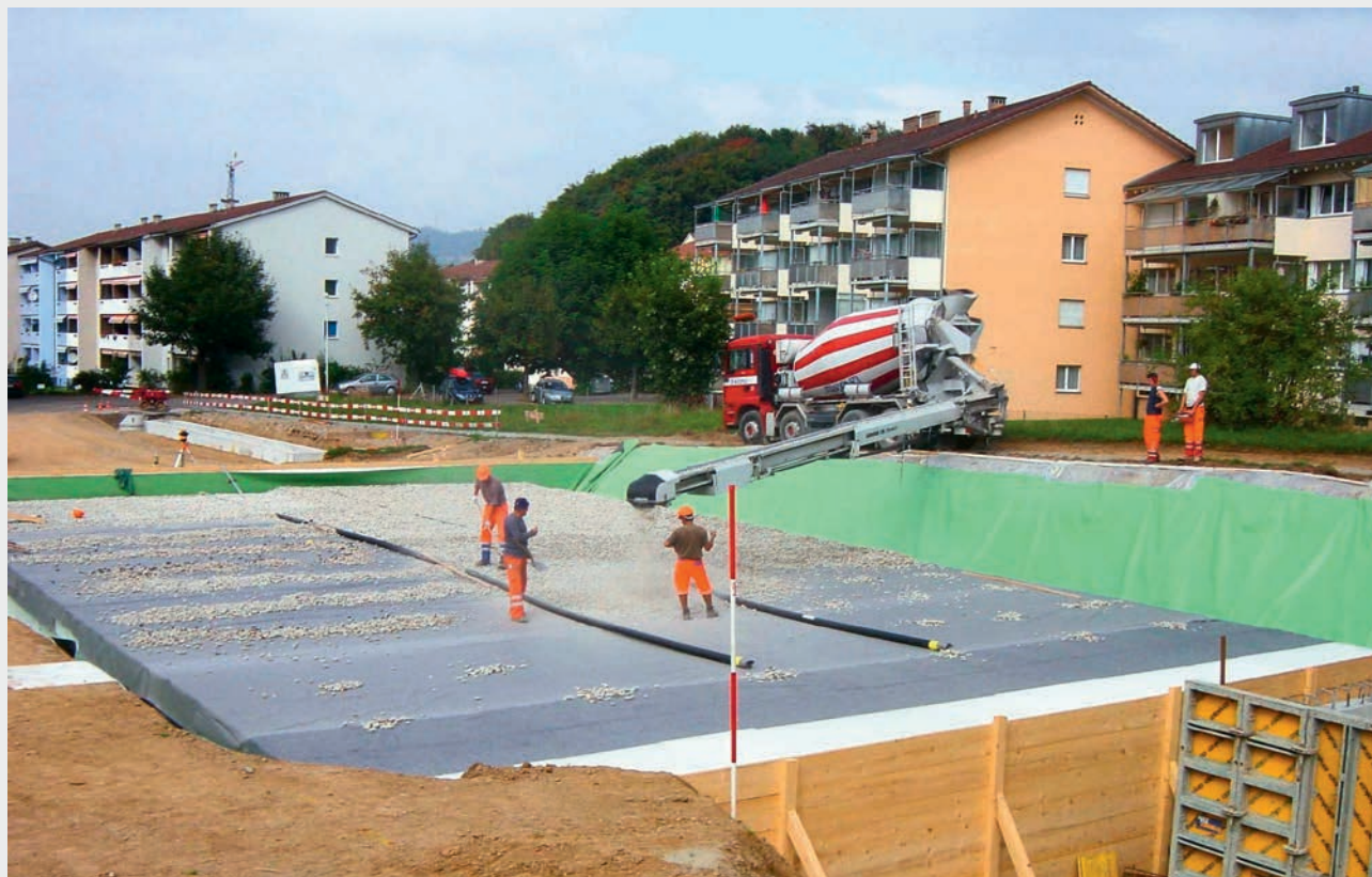
Fig. 7 Construction du plus grand système d'infiltration souterrain de Suisse dans le nouveau quartier Oberfeld de la commune d'Ostermundigen.
