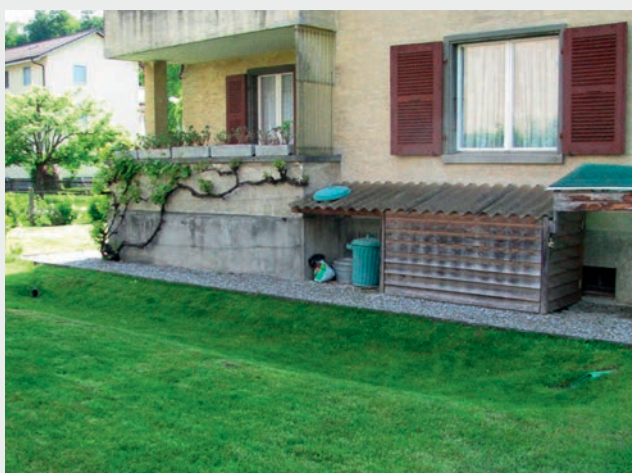
Fig. 3 Infiltration par cuvette pour une ancienne construction avec couverture végétale. Les éventuels polluants contenus dans les eaux pluviales des toits et places sont retenus par le passage du sol et partiellement décomposés par des microorganismes.
