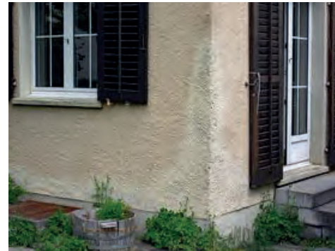
Reparaturstelle an einer Fassadenecke
