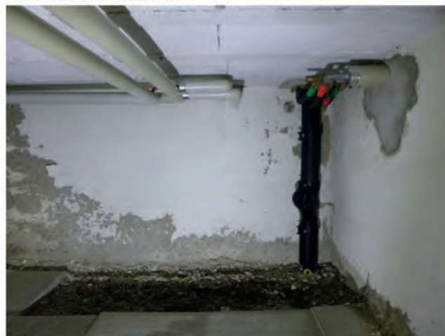
Grabenacker 29, Keller Fernwärmeheizung und neuere Leitungen kein Asbestverdacht
