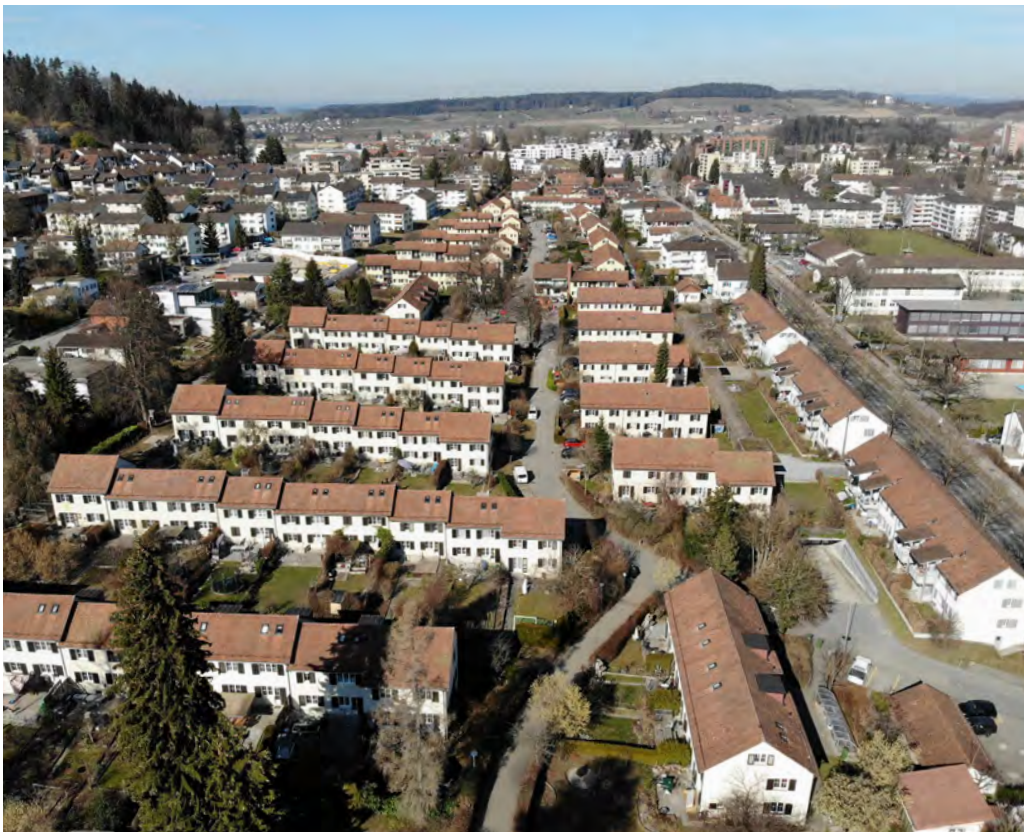
Abb. 2: Siedlung Grabenacker, Blick aus Richtung Süden
