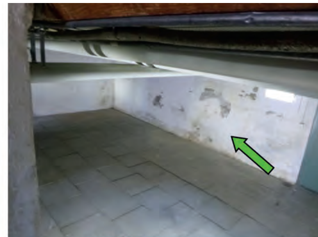
Grabenacker 29, Keller EG-VP1, Verputz (Mischprobe) kein Asbest
