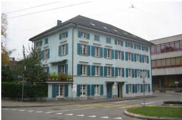
Abb. 43. Wildbachstrasse 30 & 32, Technikumstrasse 59 & 5 v.l.n.r. (Denkmalpflege Winterthur)
