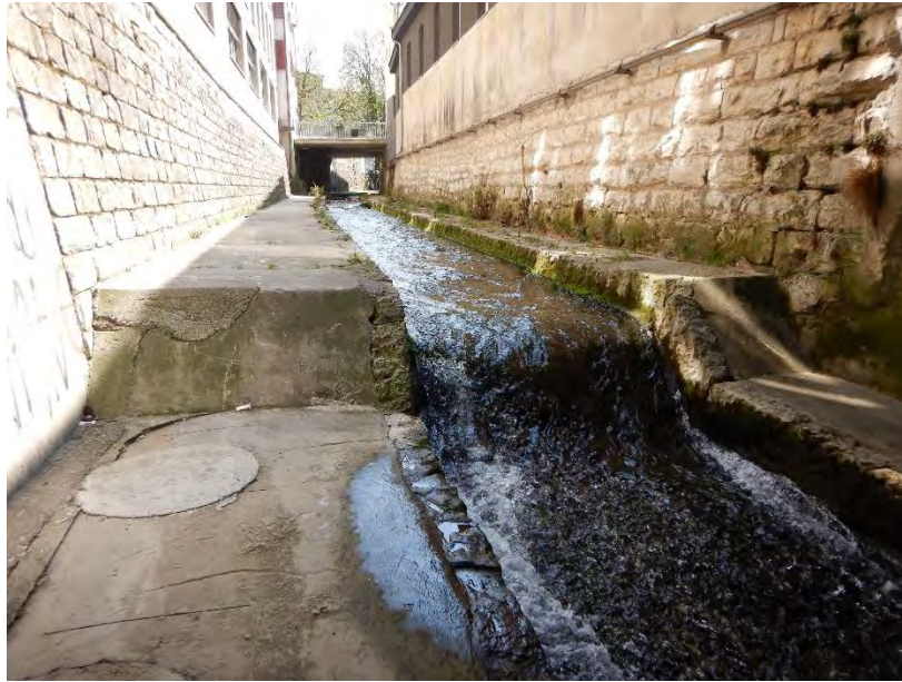
Abbildung 13: Blick flussaufwärts. Schwelle am Ende des Projektperimeters. Seitliche Ufermauern mit unmittelbar anschliessenden Hausfassaden
