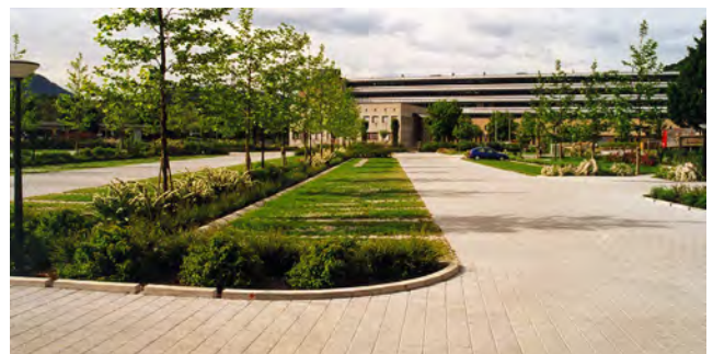
Abb. 39: Beispiel für Rasenfugenpflaster als Parkplatz, Lugano Suglio
