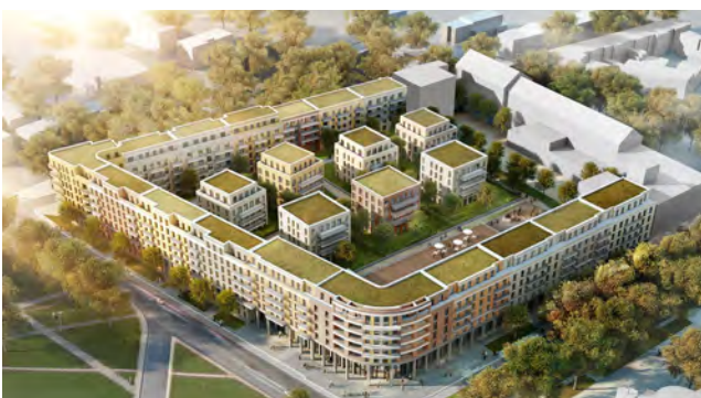
Abb. 75: Dachflächen im Goethequartier in Offenbach
