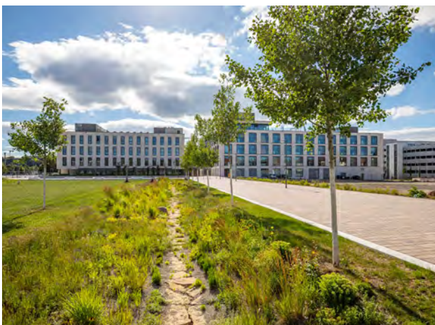
Abb. 78: Eine Sickermulde filtert das Regenwasser, bevor es in die Zisterne fließt.
