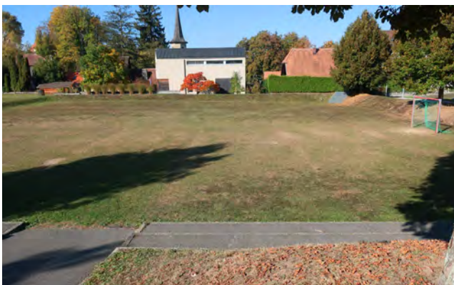
Abb. 82: Flutbarer Spiel- und Fussballplatz in Freiburg. In der hinteren Ecke ist das Einlaufbauwerk in die Kanalisation sichtbar.
