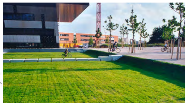
Abb. 31: Retentionsmulden Scharnhäuser Park
