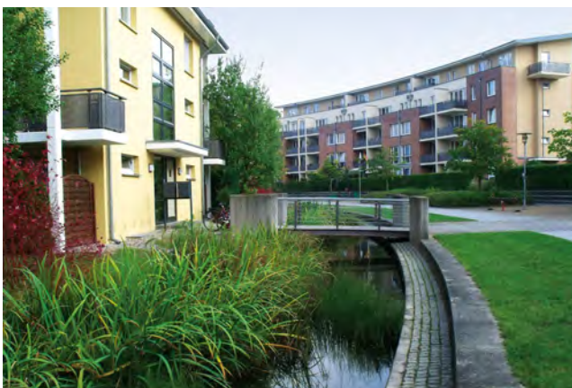
Abb. 56: Wohnpark Trabrennbahn Farmsen mit Regenwasserkanal
