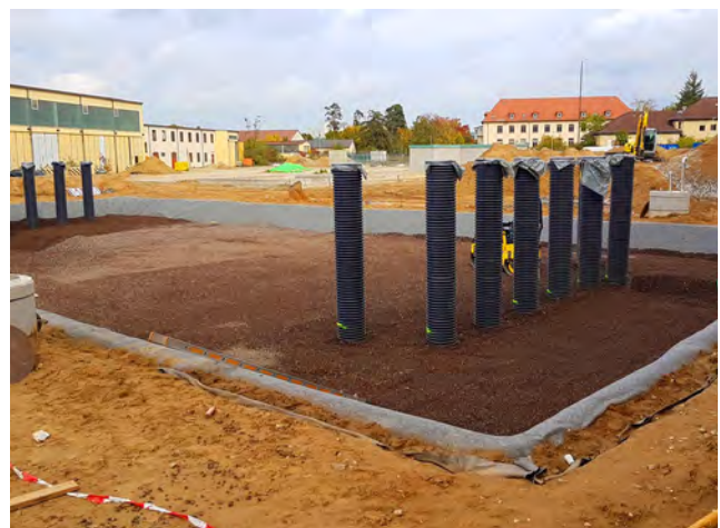
Abb. 67: Die untersten Lagen bestehen aus Kunststoffelementen (Löschwassernutzung), die weitere Auffüllung hier aus Lava (hohes Porenvolumen).
