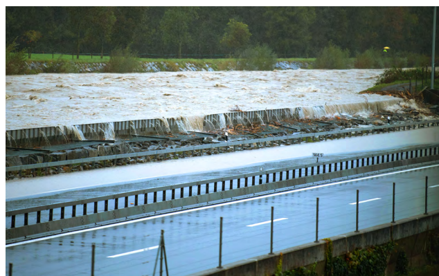
Abb. 92: Flutbarer Abschnitt der Autobahn A2 zwischen Attinghausen und Seedorf (UR) während des Hochwasserereignisses vom Oktober 2020
