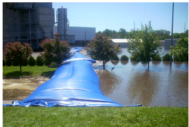
Abb. 93: Mobiler, mit Wasser gefüllter Schutzdamm
