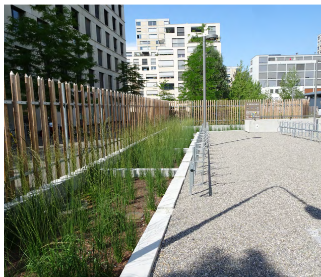
Abb. 59: Offene Gräben für Verdunstung und Versickerung
