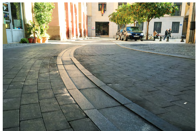
Abb. 89: Historische Altstadt Valencia mit Entwässerungsrinnen
