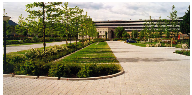
Abb. 39: Beispiel für Rasenfugenpflaster als Parkplatz, Lugano Suglio
