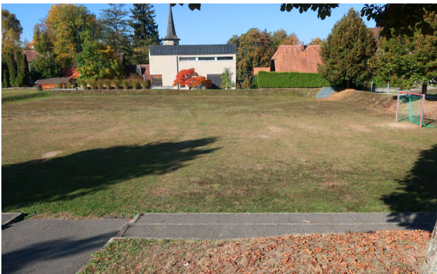
Abb. 82: Flutbarer Spiel- und Fussballplatz in Freiburg. In der hinteren Ecke ist das Einlaufbauwerk in die Kanalisation sichtbar.
