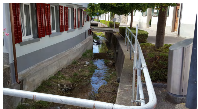
Abb. 34: Über die Strasse gelangt der Oberflächenabfluss zurück in den Talerbach.
