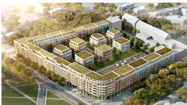
Abb. 75: Dachflächen im Goethequartier in Offenbach
